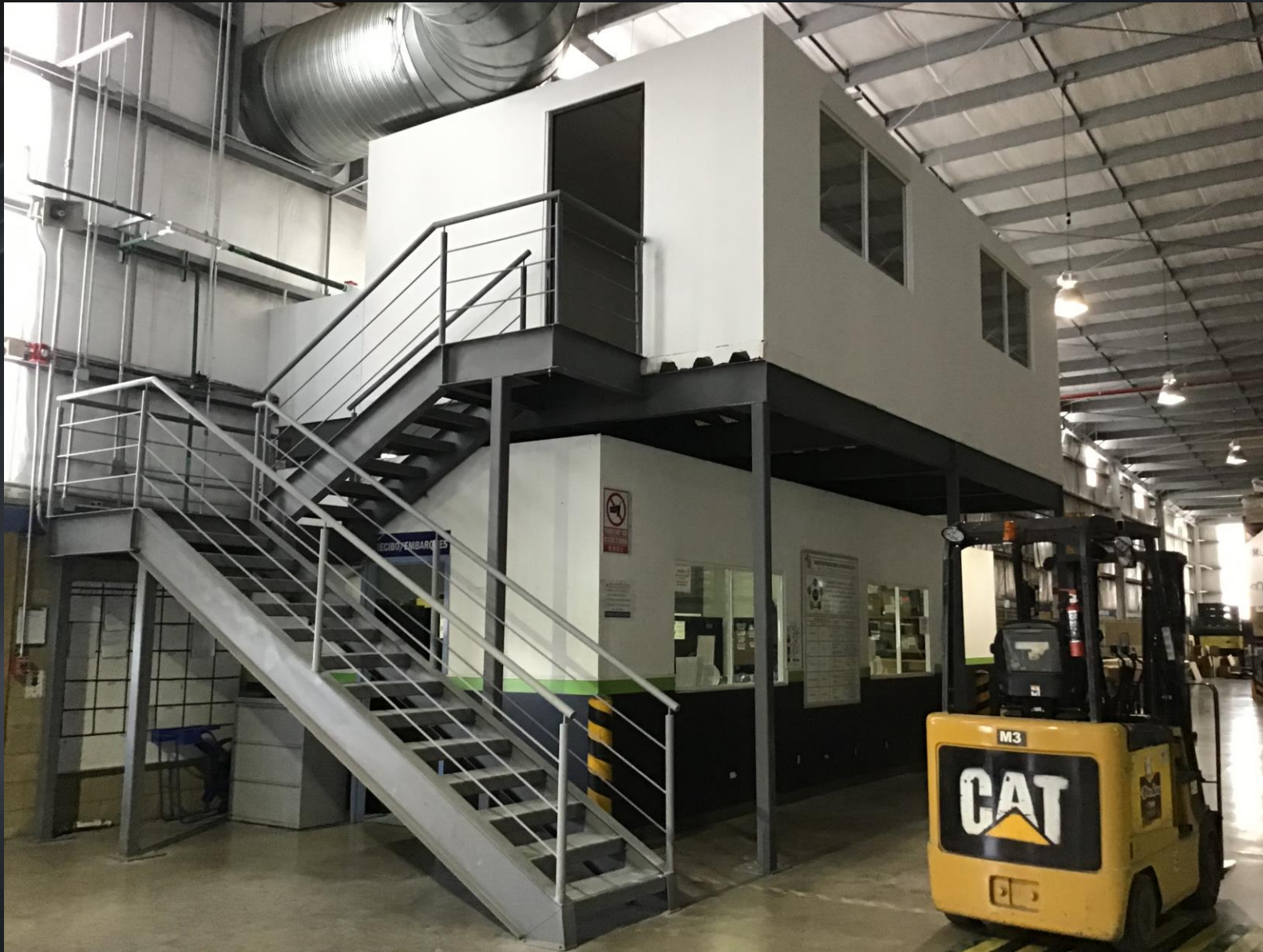
Mezzanine, NEATON S.A. de C.V.
